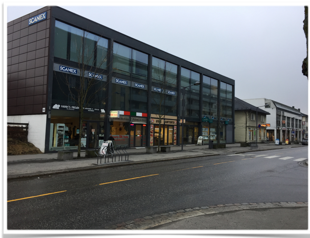
Bilde: Kontoret på Strømmen, 3 etasje
